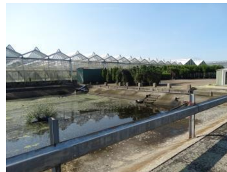
Opslag water in open bassin-> behoud B1
