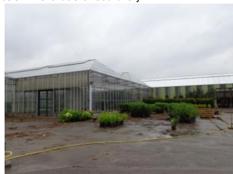
Zicht op zuid-en westgevel hoofdvolume
