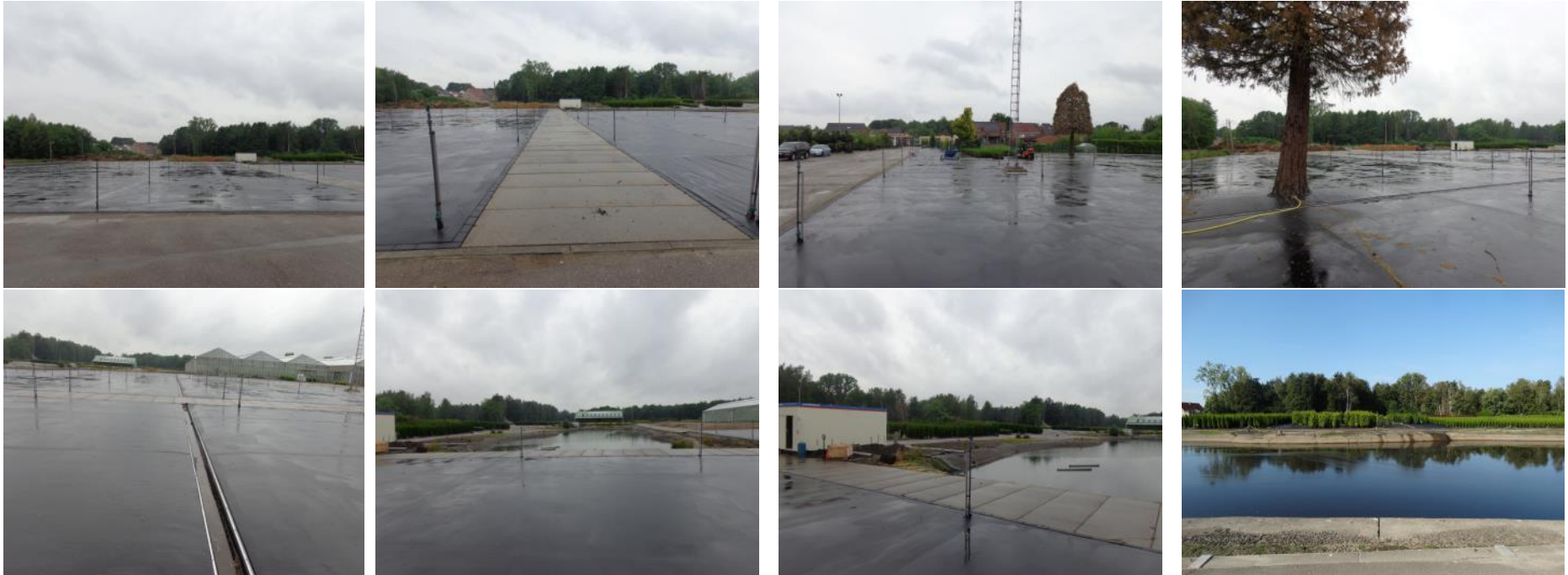
Zone ten westen van hoofdgebouw waar een ophoging van circa +0.70 m is gebeurd, sloop boogloods op perceel 390m en inplanting van een pompinstallatie in container en aanleg kweekbedden/ betonnen verharding-> regularisatie is vereist
