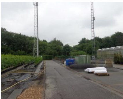
Zicht op noordgevel hoofdvolume en kweekbedden. In de achtergrond perceel 262B aangeduid als ontsluiting op BPA Schansdijkstraat-> ontsluiting blijft langs de Steenweg
