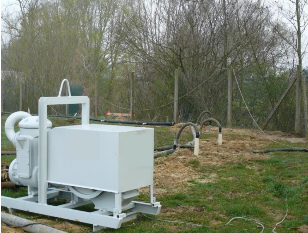
Figuur 2: uitvoering van een filterbemaling met zuigerpompen
